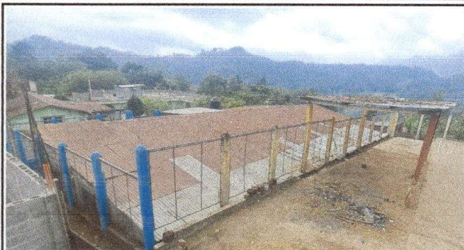
Foto 1: CUBIERTA DE LAMINA, Sustitución de lámina, por lámina troquelada aluzinc calibre 26, Sustitución de capote de lámina para lamina troquelada, Sustitución de elementos de fijación
