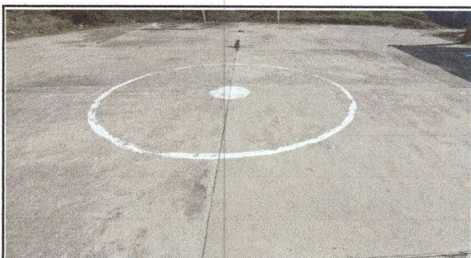
Foto 4: CUNETA DE CONCRETO, Pintura de marcaje de cancha polideportiva
