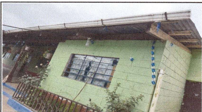
Foto 3: CANALES Y BAJADAS DE AGUA PLUVIAL, Sustitución de canal de metal
